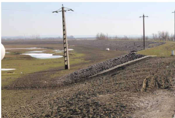
Digul de pe Valea Prutului, din dreptul localității Rânzești, care protejează de inundații suprafețele agricole
