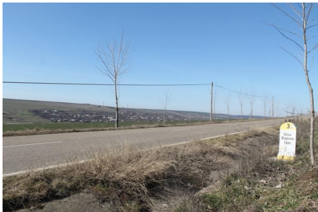
Drumul DJ 44 Fălciu-Odaia Bogdana
