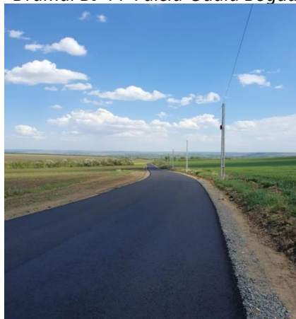
Drumul Fălciu- Copăceana
